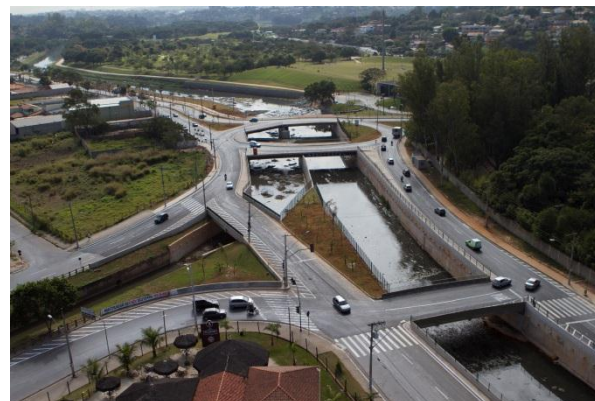
DRENAGEM URBANA EM BELO HORIZONTE/MG Córrego Ressaca
