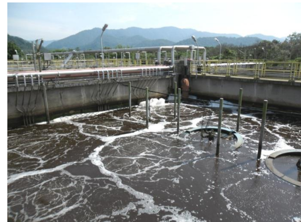
ESGOTAMENTO SANITÁRIO NA BAIXADA SANTISTA/SP ETE Mongaguá – Tanque de aerção
