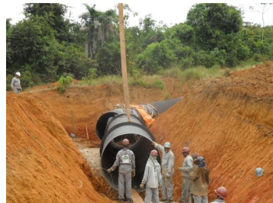
ABASTECIMENTO DE ÁGUA EM SALVADOR/BA Assentamento da adutora de água bruta - Travessia Braskem
