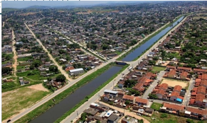
DRENAGEM URBANA NA BAIXADA FLUMINENSE/RJ Desassoreamento do rio Botas e implantação de vias marginais – Belford Roxo
